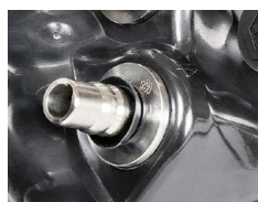
Q-ODC socket on MLUH HV
