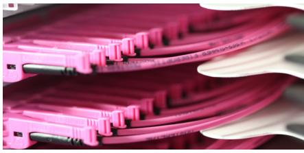
Le système de gestion de fibre LISA accueille jusqu'à 1500 ports couplés dans une même baie. Le nombre de ports peut être doublé sur la largeur d'une seule dalle au sol en plaçant deux baies dos à dos.
